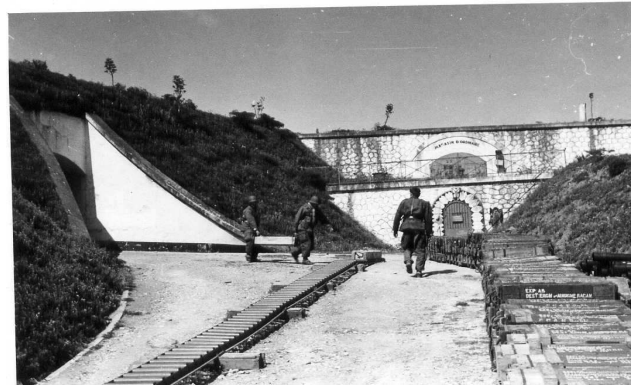
Approvisionnement au dépôt de munitions du fort d'Alger.(1)
